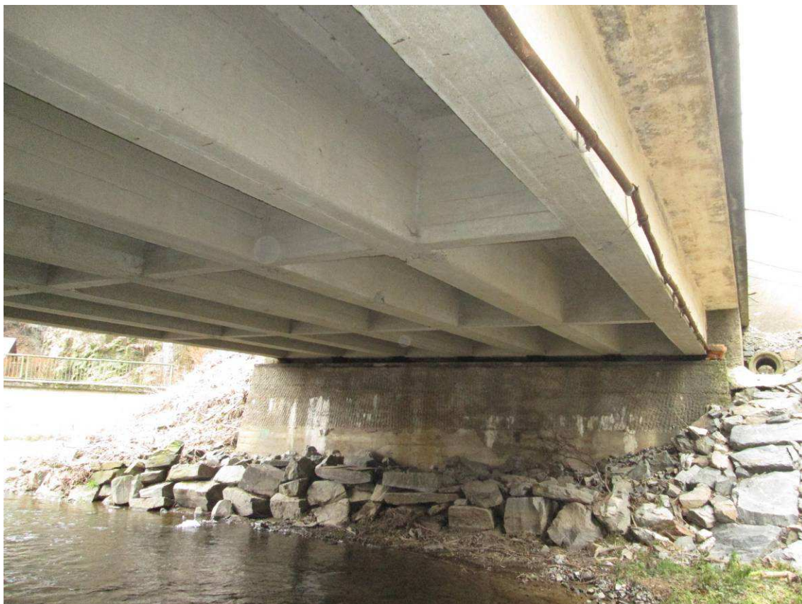
Pohled na OP2 – trhliny s výluhy. Výluhy na spodním líci konzoly NK.
